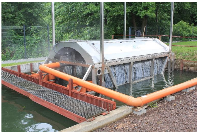
Rysunek 5. Filtr bębnowy przed instalacją AquaSyste Typ 200.
