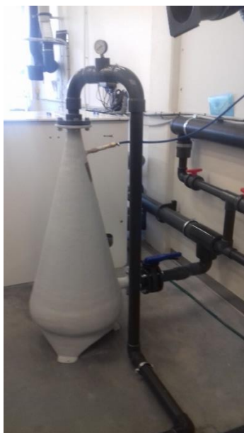
Rysunek 8. Stożek do natleniania w farmie pilotażowej krewetek w Kłajpedzie projektu InnoAquaTech
