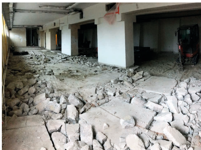
Pomieszczenia na etapie prac budowlanych realizowanych ze środków MIR-PIB
