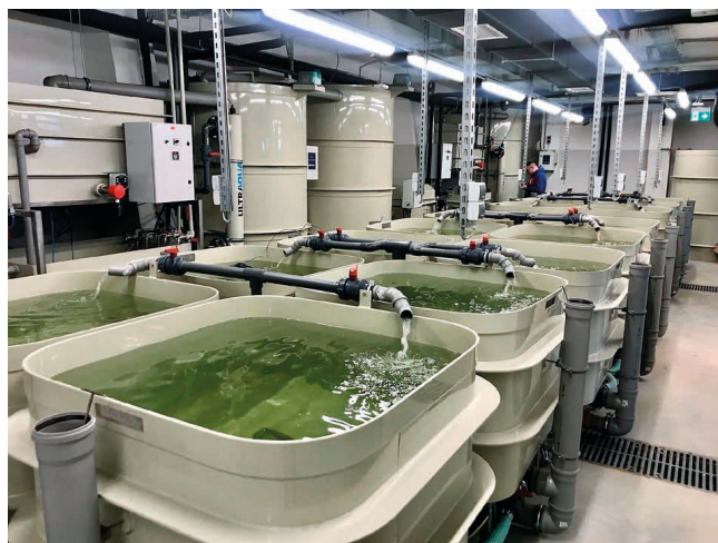
Pomieszczenie hodowlane po modernizacji i wyposażeniu
