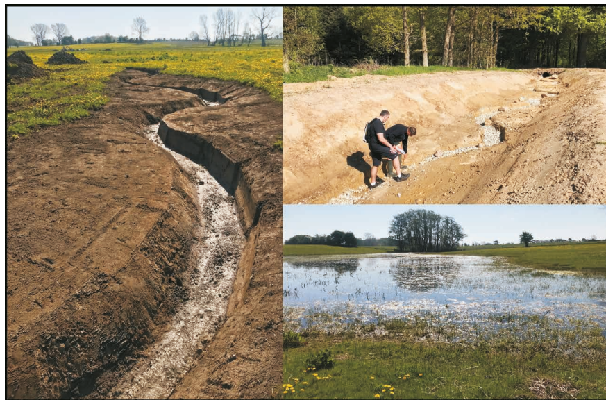
Fot. 3. Prace ziemne w rejonie jednej z zatok w Danii, prowadzone w celu utworzenia tzw. „pike factory” – oficjalne otwarcie miało miejsce w marcu 2019 r. W okresie wiosennym, łąki graniczące z zatoką będą w sposób kontrolowany zalewane, co umożliwi wejście tarlakom na tarło, a następnie spłynięcie narybku do zatoki. Takie obszary były już wcześniej tworzone w Szwecji.
