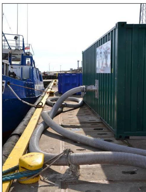
Fot. 8. Przewody rurowe do hydraulicznego wyladunku ryb z kutrów rybackich (fot. MIR-PIB)
