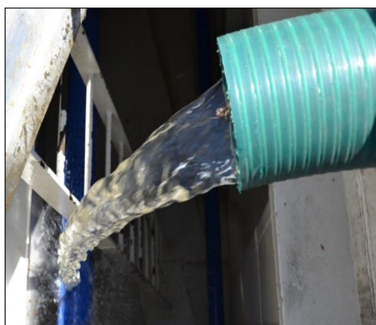
Fot. 31. Wprowadzanie oczyszczonej wstępnie wody technologicznej do zbiornika kutra (fot. MIR-PIB)
