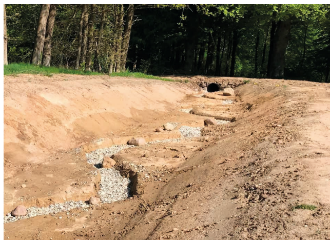
Fot. 5. Przekierowanie strumienia umożliwiające zalanie pobliskich łąk nad Præstø Fjord – Dania (fot. Dariusz Fey).
