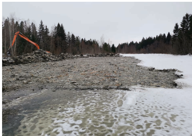
Fot. 3. Prace ziemne wykonane w ramach pogłębienia mokradła – Finlandia (autor: Juha Ojajarju).
