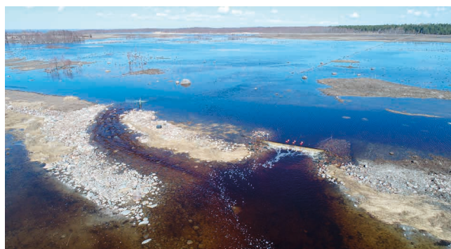
Fot. 4. Zalane tarlisko po przebudowie wraz ze zmodernizowanymi kanałami odpływowymi wiosną 2022 roku – Estonia (fot. Roland Svirgsden).
