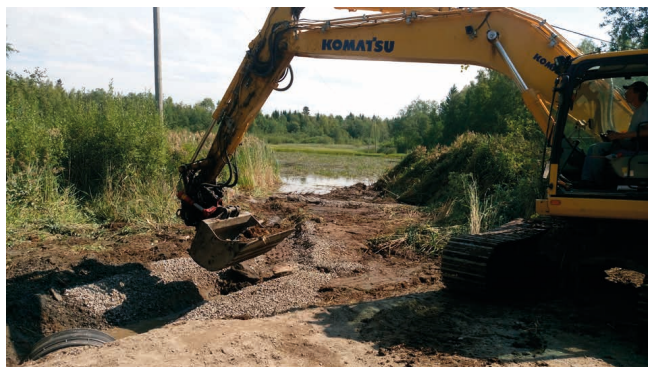
Fot. 2. Udrożnienie kanału łączącego rozlewisko z morzem – Finlandia (autor: Juha Ojajarju).
