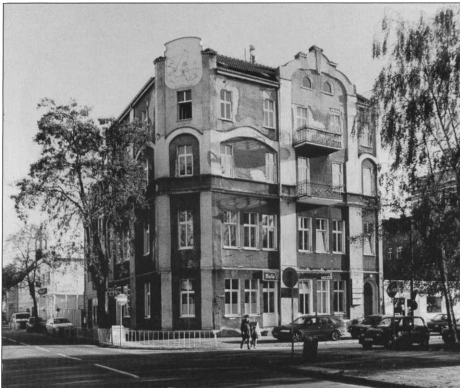
Budynek Stacji Badawczej MIR w winouj ciu
