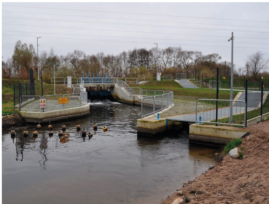
Fot. 2. Jaz regulujący przepływ wody w starym korycie Redy. Po prawej stronie znajduje się wejście do przepławki od strony dolnej wody (fot. A.M. Lejk).
