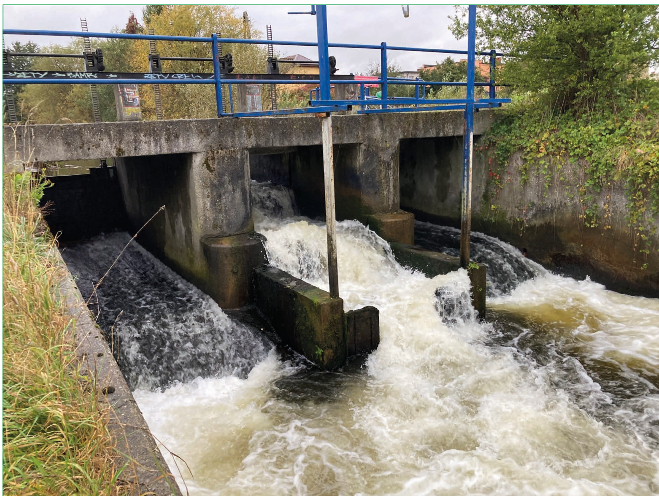
Fot. 1. Jaz piętrzący rzekę Redę w miejscowości Ciechocin. Obecnie istniejąca przepławka zlokalizowana jest w środkowym prześle jazu (fot. A.M. Lejk).
